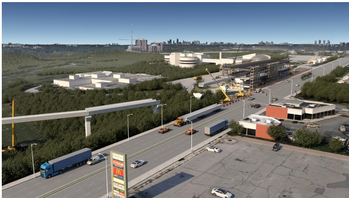
Figura 7. Proceso constructivo estación y viaductos en Toronto
