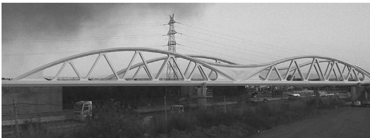
Figura 1. Vista del paso
