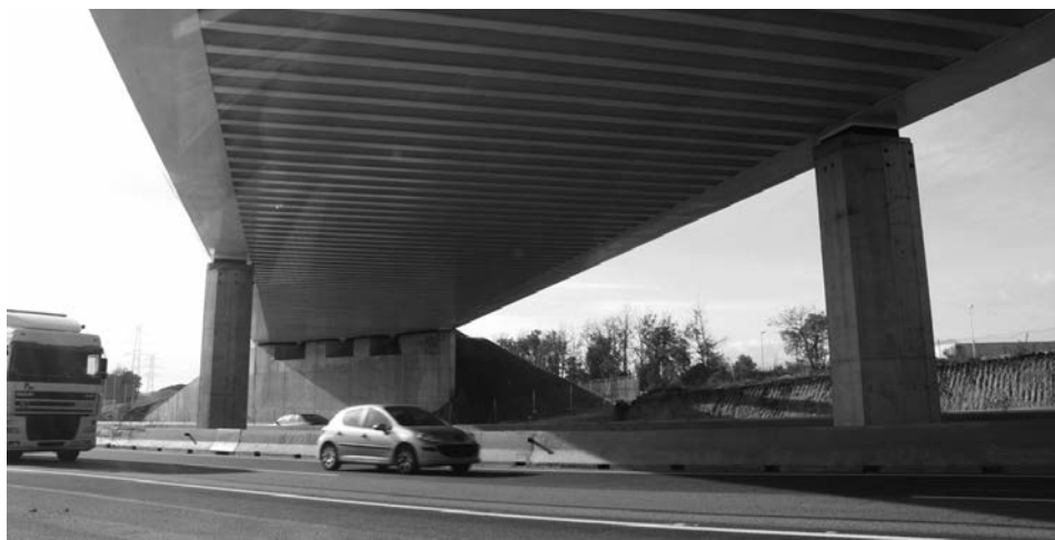
Figura 7. Vista inferior del paso
